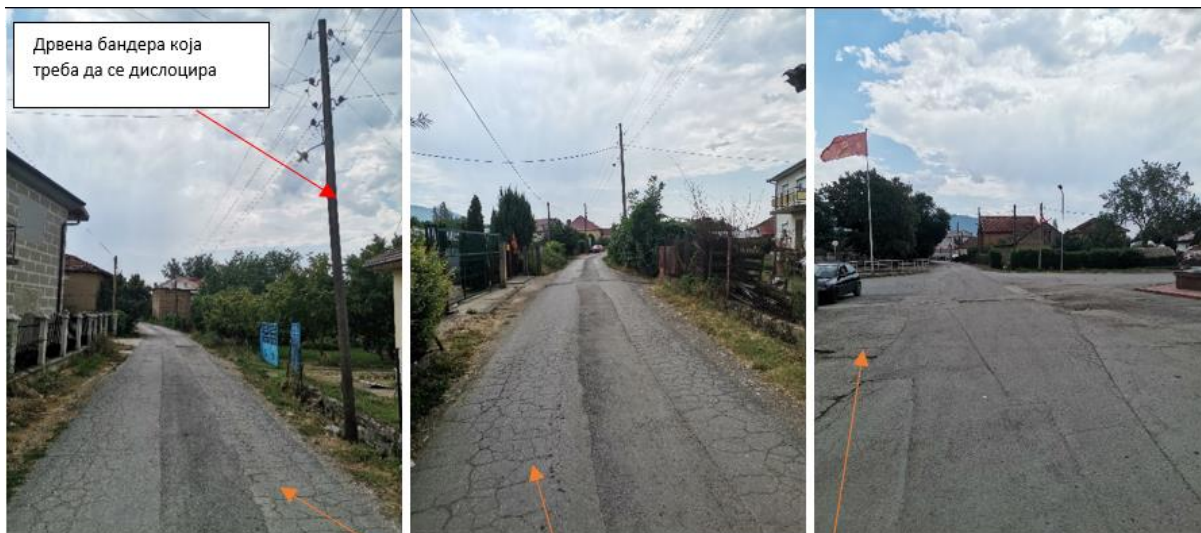
Моментална состојба на улицата со пукнатини, дупки и разни други оштетувања на асфалтот:
